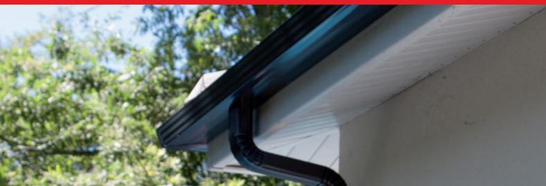
INOA de DAL'ALU est une gouttière innovante avec un système d'étanchéité intégré aux accessoires.
