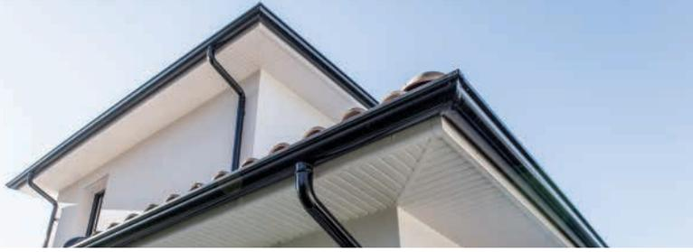
Associés aux différents modèles de gouttières, **les tuyaux de descente** sont un élément indispensable à l'évacuation des eaux pluviales. Ils doivent permettre un bon écoulement tout en conservant une étanchéité optimale pour protéger la façade des bâtiments et maisons.
